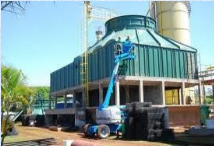
Tratamiento Químico de Circuitos de Enfriamiento
